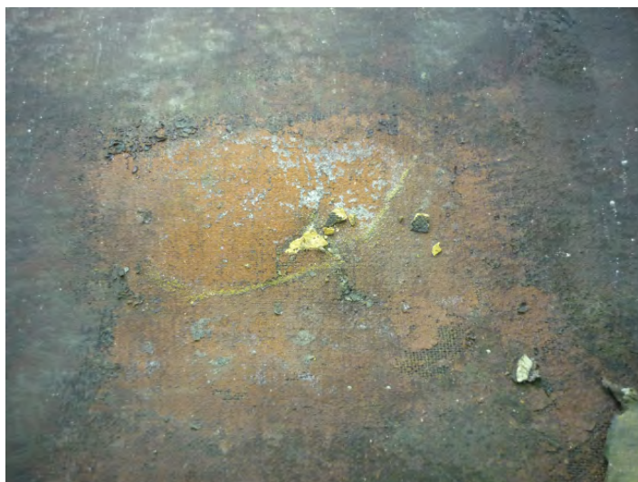
Figura 4 – Pormenor da massa de preenchimento na superfície onde se situa um dos remendos de tela, na área superior da obra.
